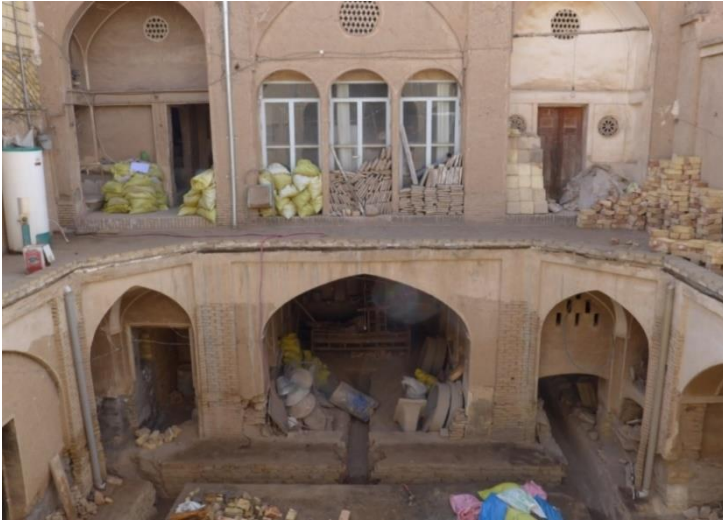
Abb. 5: Hof eines kleinen Hauses in der Altstadt
